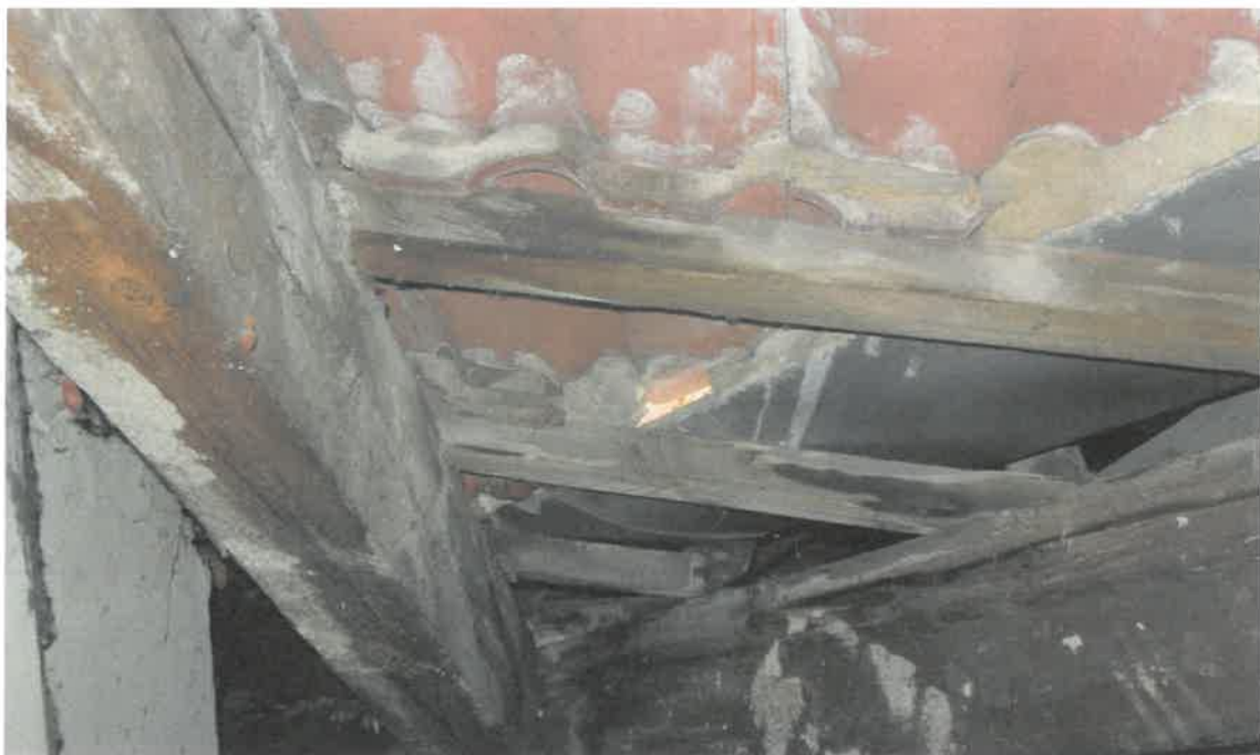
Zdjęcie nr 7 - Nieszczelny fragment dachu. Widoczne zawilgocone elementy drewniane więźby dachowej.
