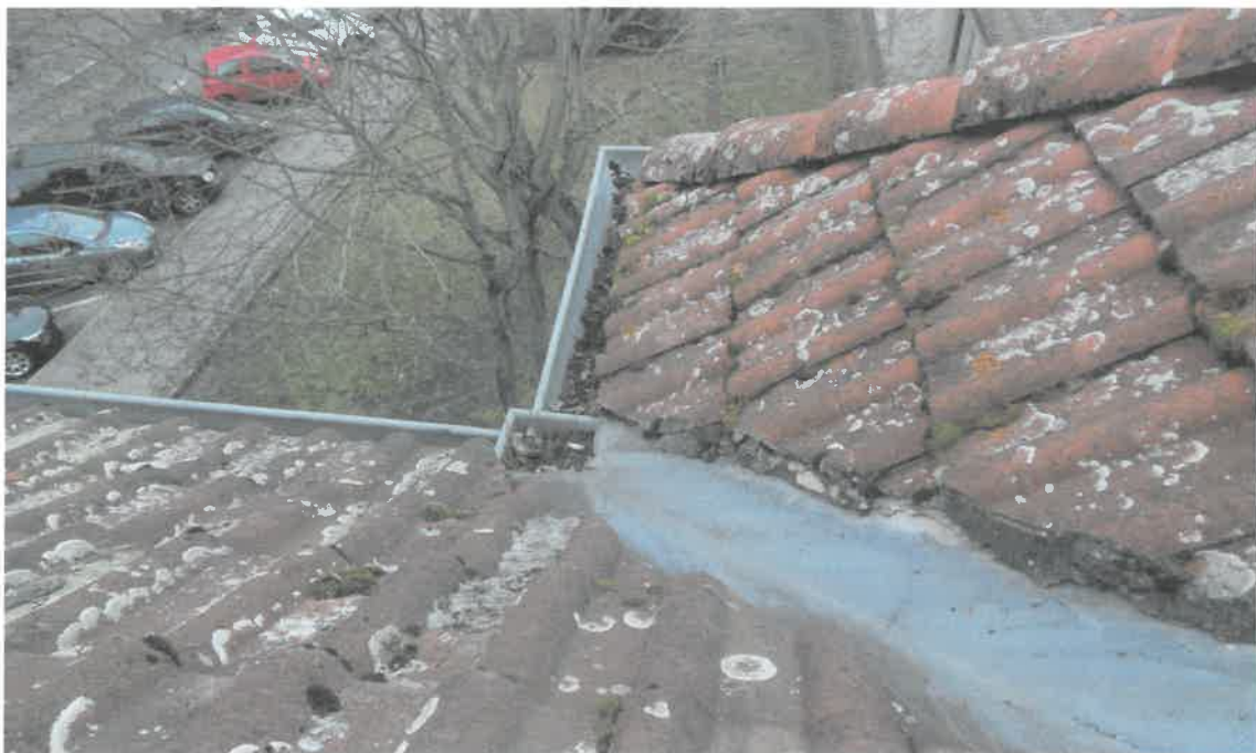
Zdjęcie nr 3 - Fragment pokrycia dachu i rynien. Widoczne wypełnione odpadami rynny i zatkany odpływ do rury spustowej.
