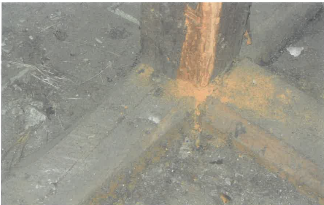
Zdjęcie nr 5 - Zniszczony słup więźby dachowej.
