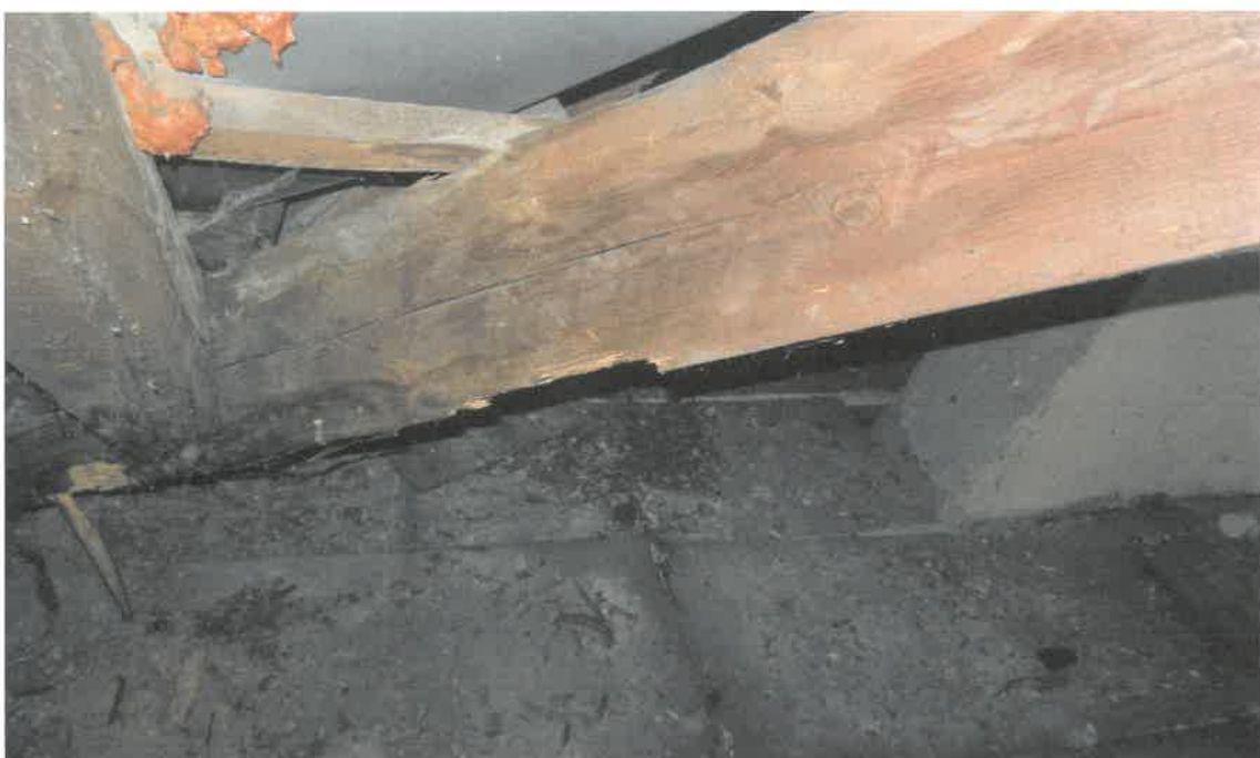
Zdjęcie nr 10 - Zniszczona belka koszowa. Próba uszczelnienia pokrycia dachowego pianką uszczelniającą.
